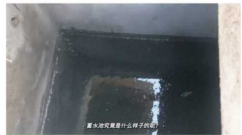
蓄水池内部是什么样子的呢？
